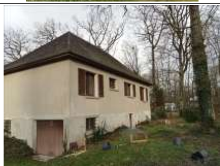
PHOTO PHDPE003 OUVRAGE : SUD EST
