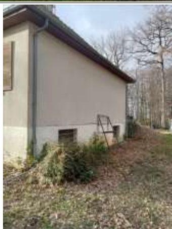
PHOTO PHDPE004 OUVRAGE : NORD-EST
