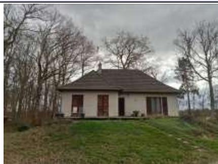
PHOTO PHDPE001 OUVRAGE : NORD-OUEST
