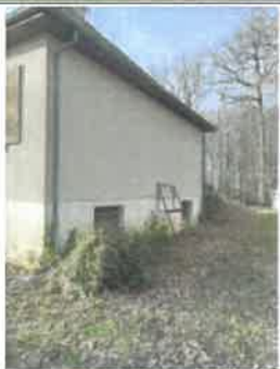
PHOTO PHDPE004 OUVRAGE : NORD-EST
