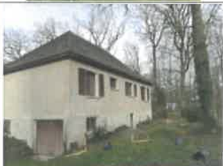
PHOTO PHDPE003 OUVRAGE : SUD EST
