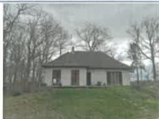
PHOTO PHDPE001 OUVRAGE : NORD-OUEST
