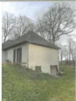
PHOTO PHDPE002 OUVRAGE : SUD-OUEST
