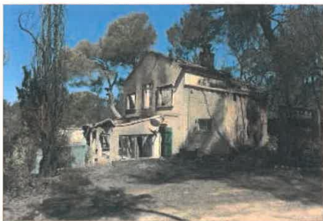
Maison non débroussaillée partiellement détruite par le passage d'un feu, Rognac (13) - source : DNF
