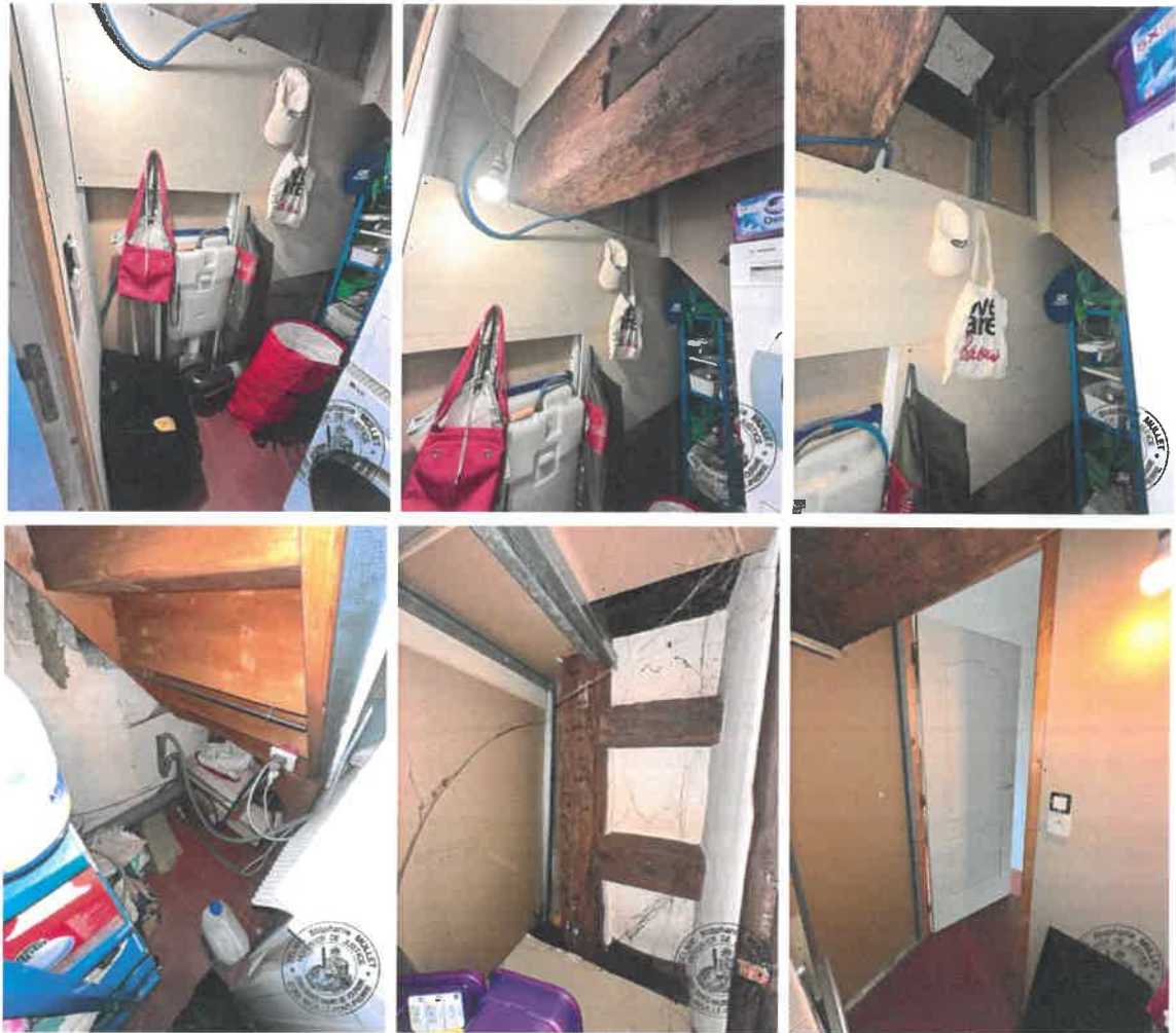
Une arrivée d'eau et tuyau d'évacuation attenant.
